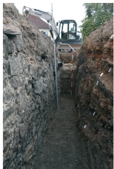
Výkop pro kanalizaci v Třeboni v ulici Valy odkryl dlouhý úsek parkánové hradby.
