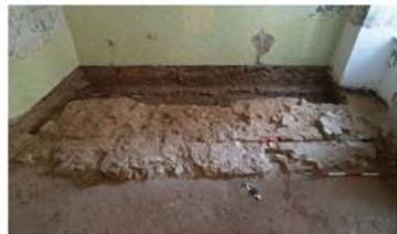
Starší příčky odkazující na odlišnou dispozici objektu proboštství v Jindřichově Hradci byly odkryty a dokumentovány v rámci probíhající rekonstrukce
